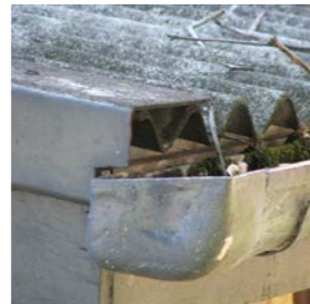
Asbestos guttering
